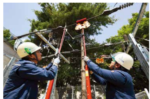
위험표지판 지상설치용 간접활선 조작봉을 개발하여 본부별 안전 우수과제 최우수상을 수상했다.
